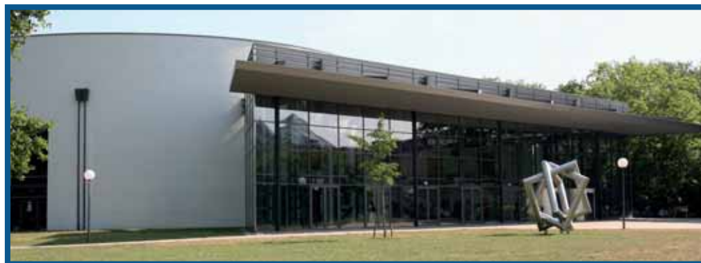
HAUCK reinigt seit Anfang des Jahres die Fassaden der 139 Gebäude der Universität Karlsruhe.
